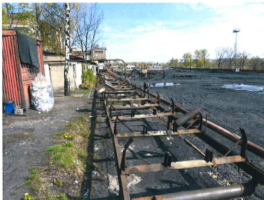
15. Pomost łączący stację przesypową nr V ze stacją przesypową nr VI 2b/3-13 (Podpora pod przenośnik taśmowy 511)
